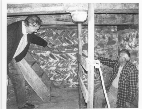
Albert Solbach (links) und Josef Alzer zeigen auf das Turm-Mauerwerk in Fischgräten-muster.
